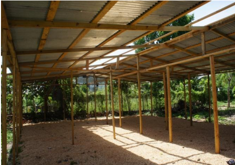
Enramada en proceso de construcción, casi terminada
